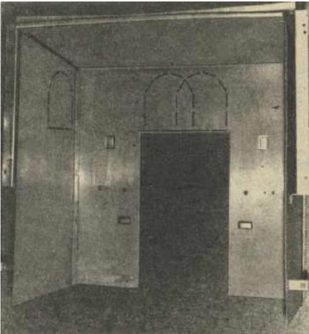
Bild 4.100. Wärmeschutz mit eingearbeiteten hinteren und seitlichen Abgasrohrdurchbrüchen
