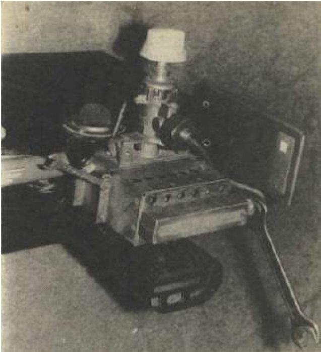
Bild 4.115. Abschrauben des Gasanschlusses am Düsenträger sowie des unteren Brennergehäuses
